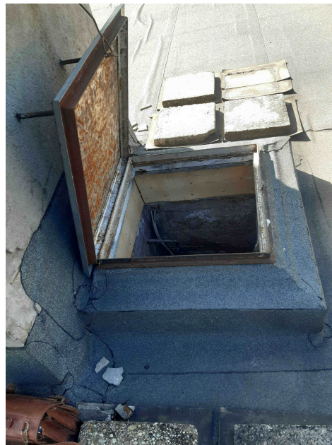
Tetőkibúvó jelenlegi állapota felülről
