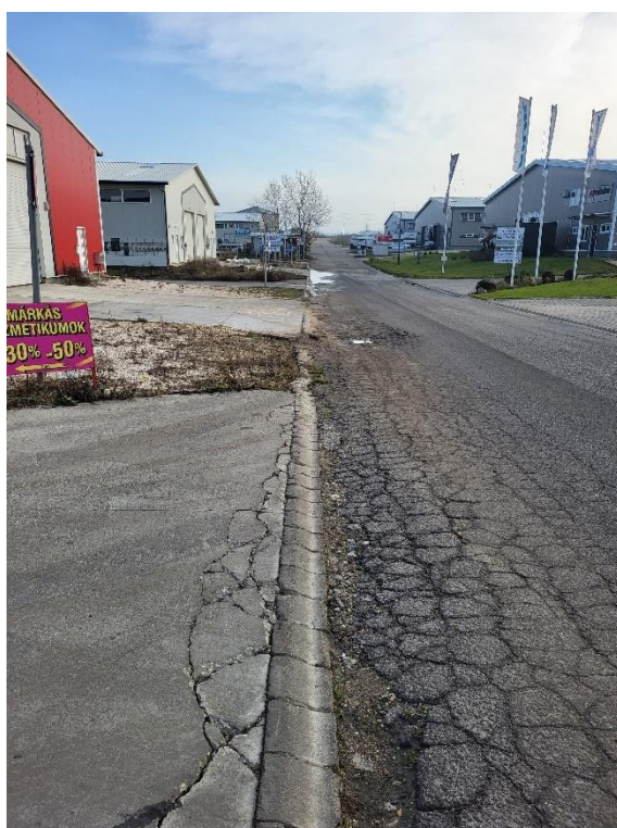
71. Mélyponthoz vezető, tönkrement burkolat
