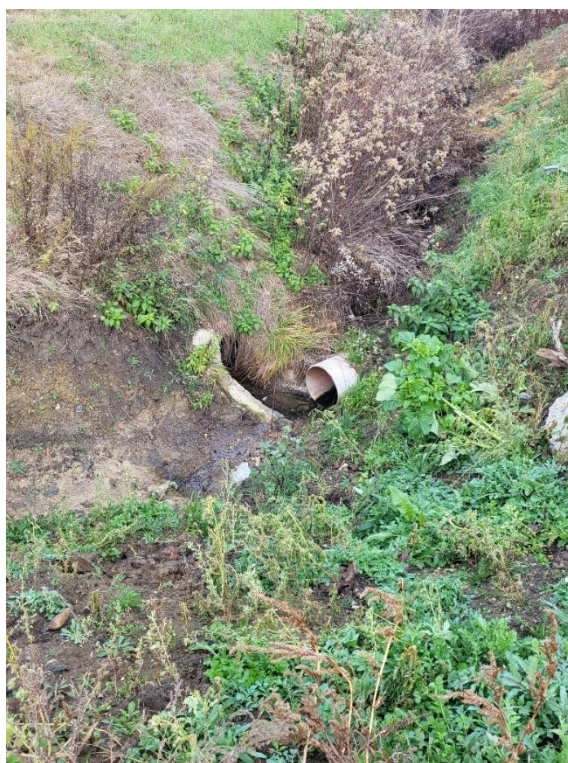
69. Csatorna átereszbe való bevezetése
