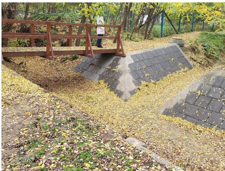
60. Északi burkolt árok csatlakozás
