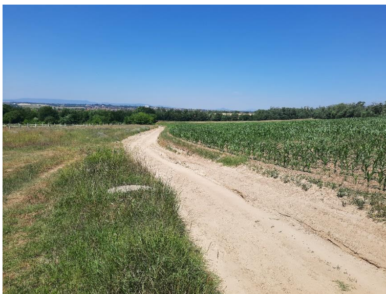
15. Északi földút tönkremenetele
