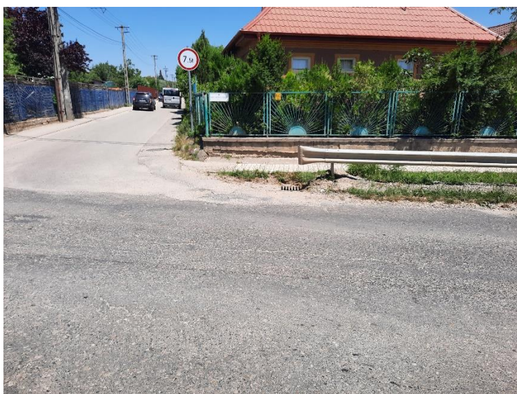
14. Bocskai köz - Kossuth Lajos u. sarkán lévő víznyelő
