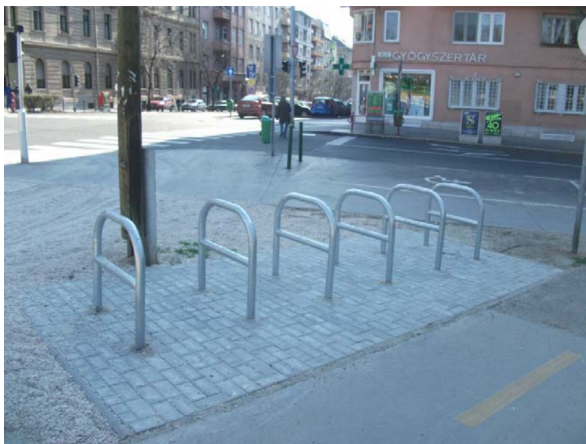
16. Fotó: U alakú kerékpártámaszok horganyzott acélból
