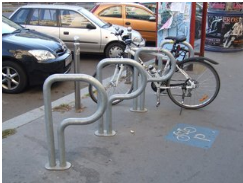
15. Fotó: P alakú kerékpártámaszok horganyzott acélból
